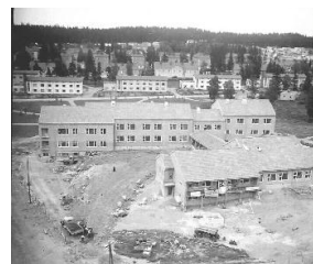
Tampellan lastentalon rakennustyömaa vuonna 1953. (kuvaaja Pekka Kosonen, Siiri)
